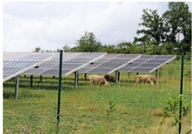
Südlich der A3 bei Weingartsgreuth steht bereits eine Photovoltaikanlage. Bei Lonnerstadt ist die nächste geplant. Foto: Andreas Dorsch (Archiv)
